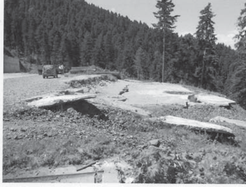
Foto 10: Maden şirketinin Cerattepe mevkiinde kendi şantiyesi için döktüğü beton platformun yaklaşık 2 yıl gibi bir sürede içerisinde heyelanla tahrip olması.
