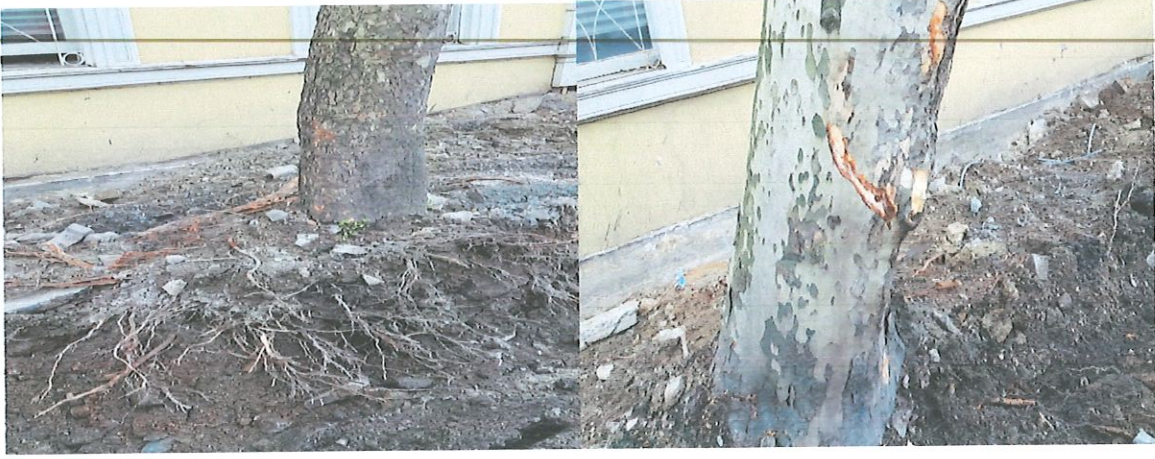
Foto 2) Ağaçlara zarar veren alt yapı çalışmalarından görüntüler
